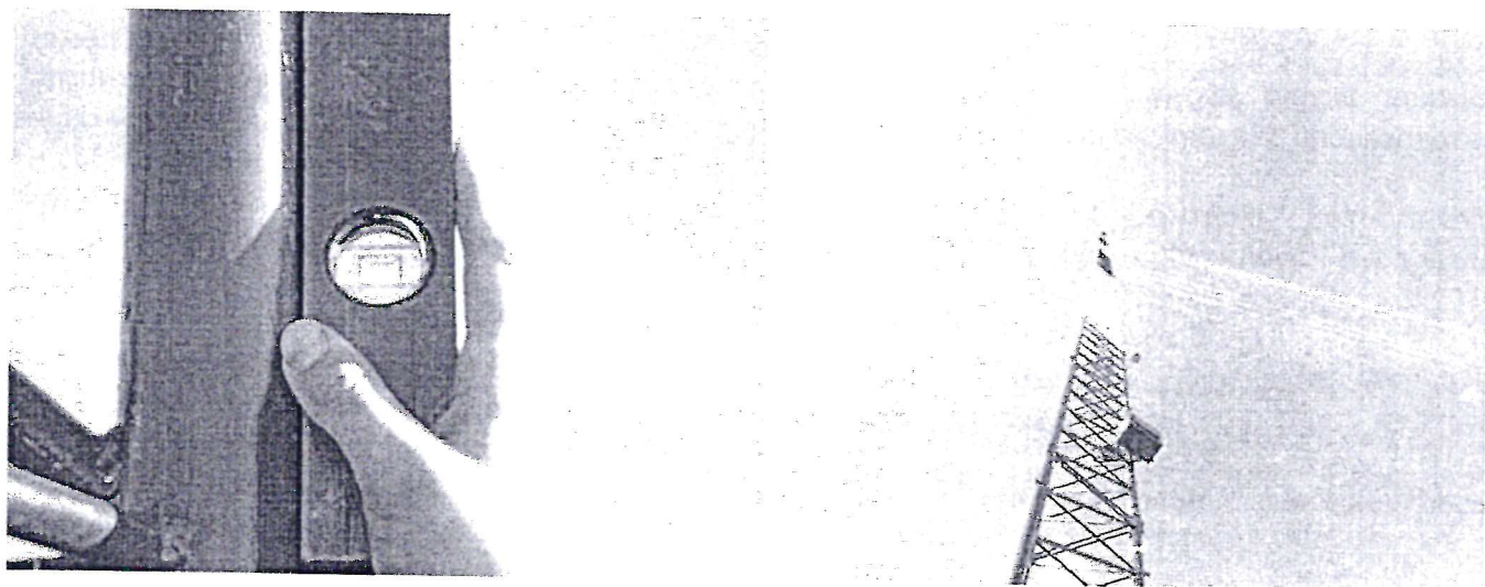
Рисунок 20 – Проверка вертикали
